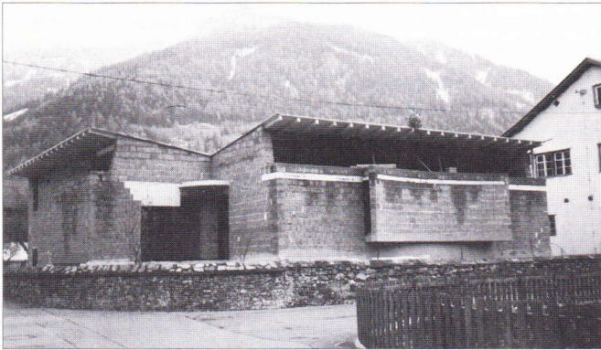
Fertigstellung des Rohbaues im November 1991
